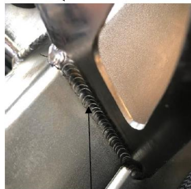
右侧底面焊接处裂纹
